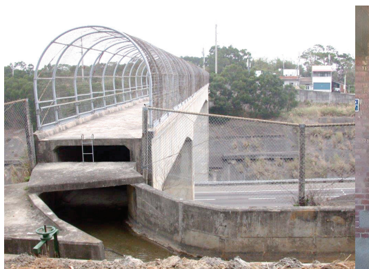
左圖：橫跨山谷的虹吸工程，另一端黃色欄杆水路依稀可見。右圖：橫跨高速公路的過水橋暗渠。（林淑英／提供）
